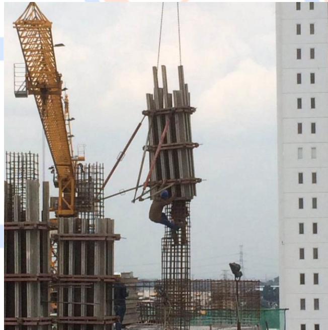
Gambar 2: Proses Pekerjaan Di ketinggian, Pemasangan cetakan kolom
