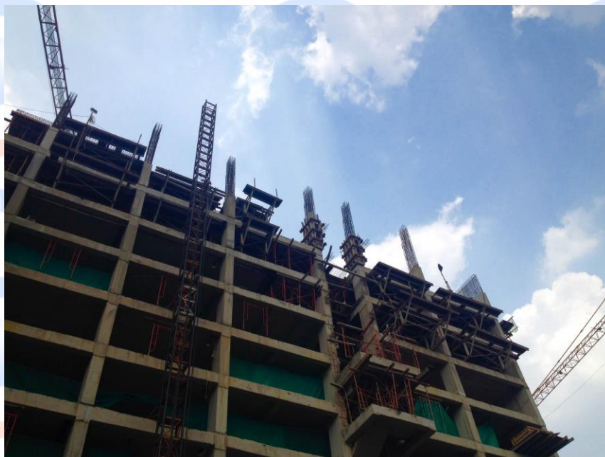
Gambar 6: Safety Net yang dipasang yang merupakan bagian program dari K3
